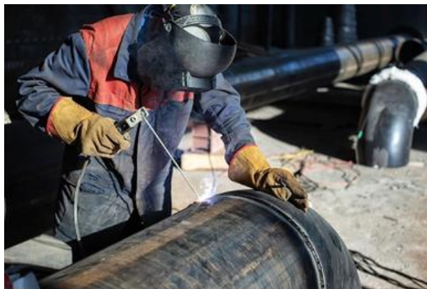
Εικόνα 5.3: Εφαρμογή συγκόλλησης με βασικό ηλεκτρόδιο
