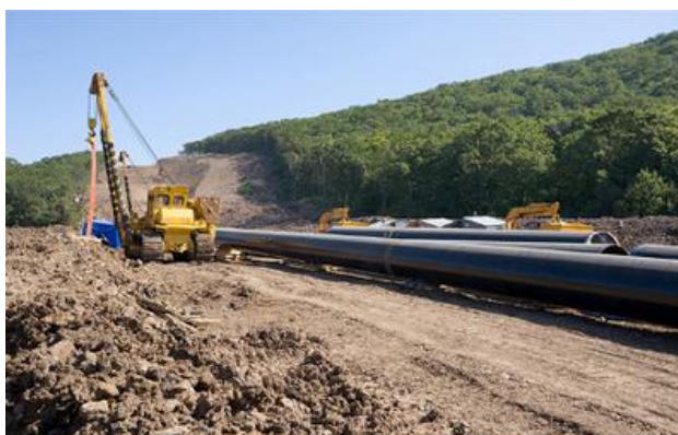
Εικόνα 9.3: Εγκατάσταση αγωγού πετρελαίου
