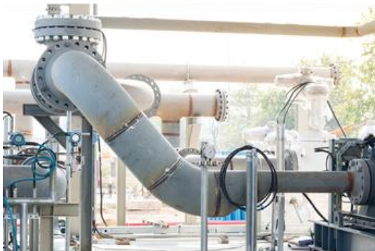
Εικόνα 9.12: Συγκρότημα σωλήνα ενωμένο με φλάντζα
